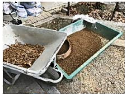
崩れた土を再利用
